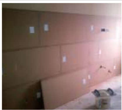
Montáž desek Wolf na masivní mezibytovou stěnu pomocí akustických hmoždinek, systém W 40.
