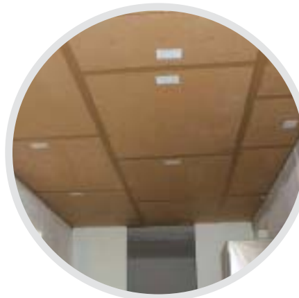
Montáž desek Wolf na žebírkový strop s podbitím z OSB desky. V případě, že je stropní konstrukce podbitá deskovým materiálem a dostatečně nosná, lze desky Wolf upevnit pomocí vrutů přímo na toto podbití.
