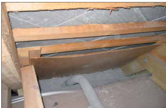
Dokonalé okopírovanie izolovaného priestoru, v tomto prípade dodatočná rekonštrukcia podkrovia.
