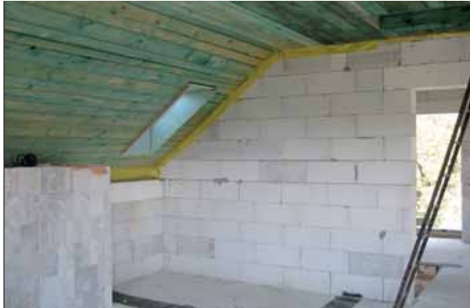
Klasické podkrovie nového rodinného domu s dreveným podbitím a následnou povrchovou úpravou formou omietky.
