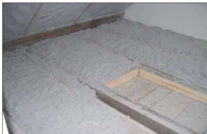
Možnosť aplikácie do podlahy s dôrazom na zamedzenie kročajovej nepriežvučnosti.
