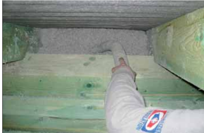
Aplikácia do šikmej časti s použitím kontaktnej paropriepustnej strešnej fólie.
