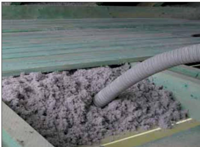
Zafúkanie vodorovnej konštrukcie podkrovia - ľudovo klieštín.
