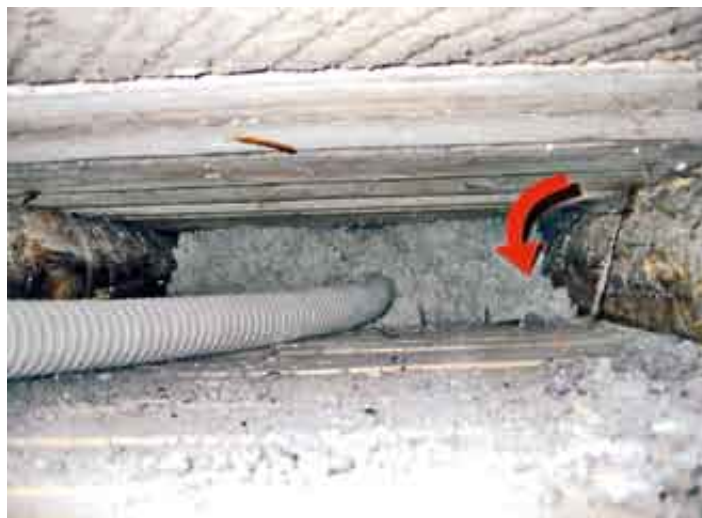
Aplikácia do štukatórového stropu – dokonalé okopírovanie izolovaného priestoru.
