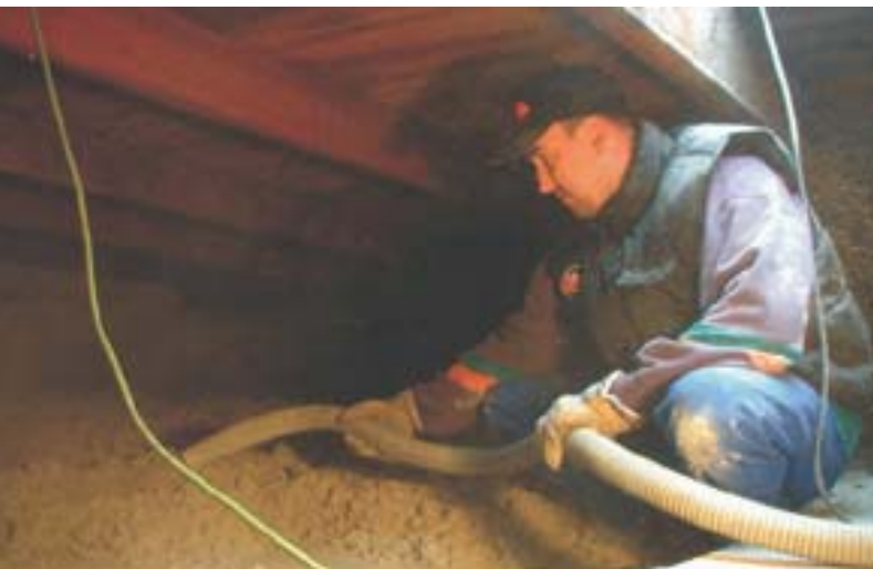
... zaizolovanie dvojplášťovej strechy rodinného domu
